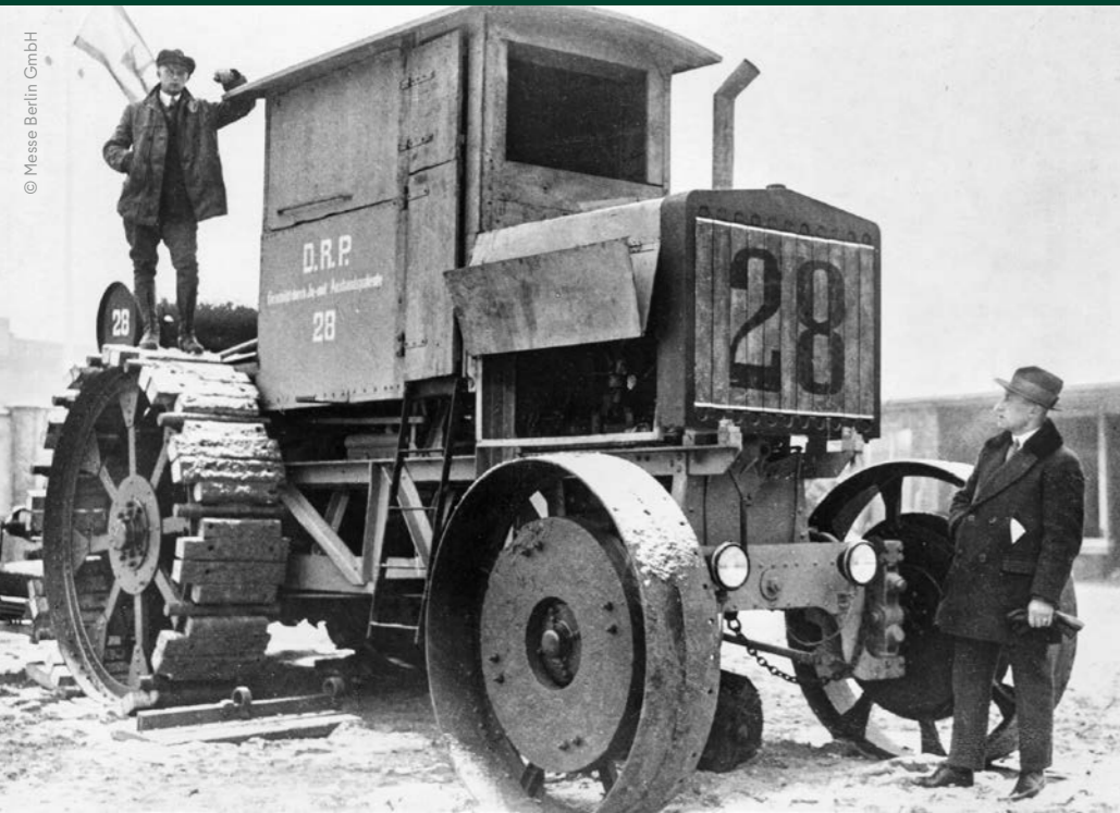
Zur Eröffnung der fünften Grünen Woche 1930 wird eine riesige Erdbearbeitungsmaschine mit 100 PS vorgestellt A massive 100 hp earth-moving machine on show at the opening of the 5th Grüne Woche in 1930
