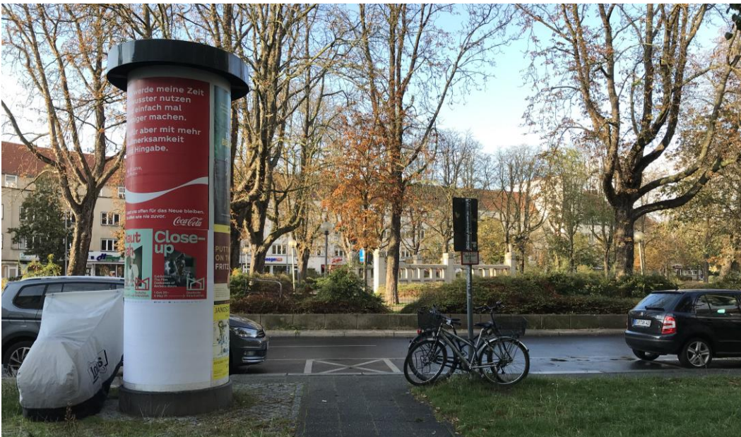
Fehlende Zugänglichkeit der Platzfläche aus südöstlicher Richtung
