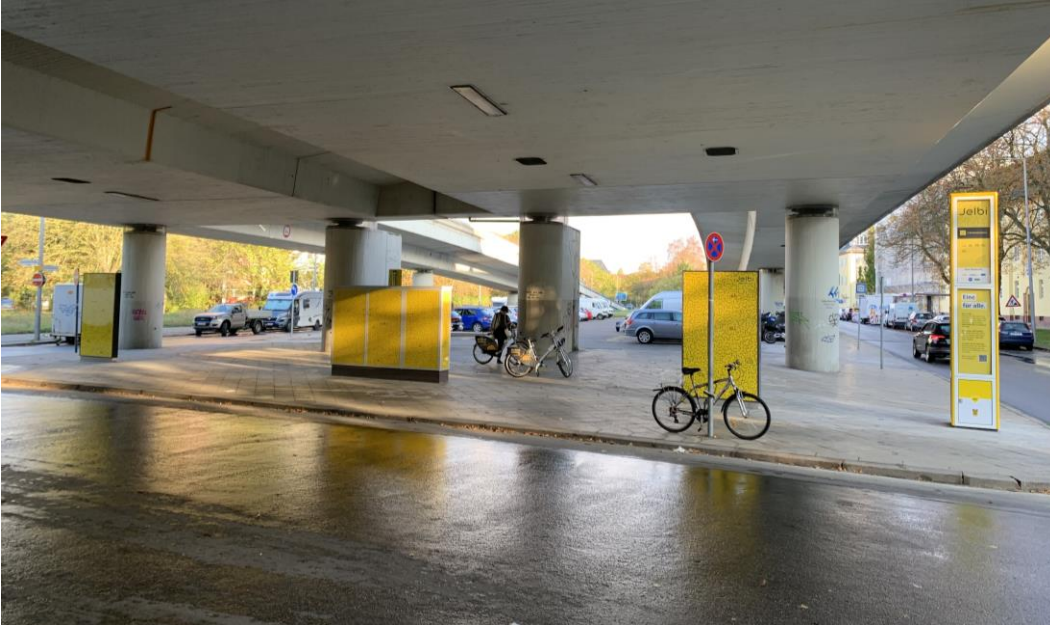
Neue Jelbi-Station unterhalb der Brücke
