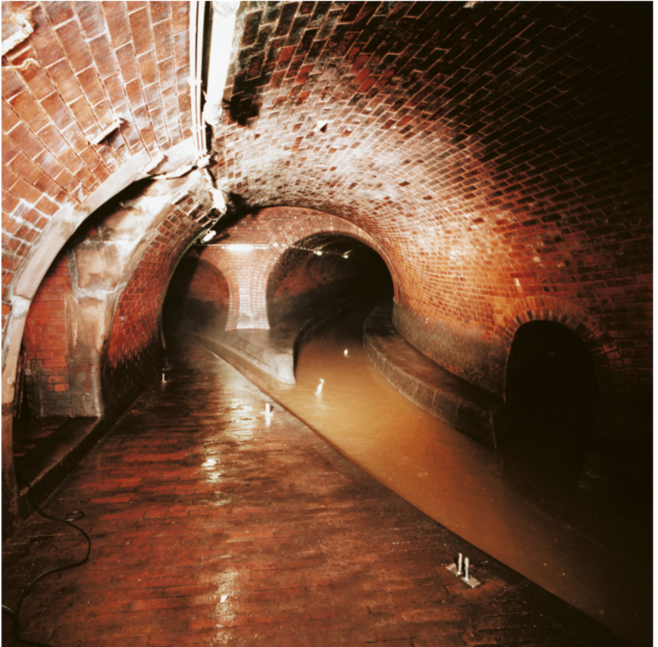
Abbildung 6.6-2 Mischwasserkanal Hohenstaufenstraße
