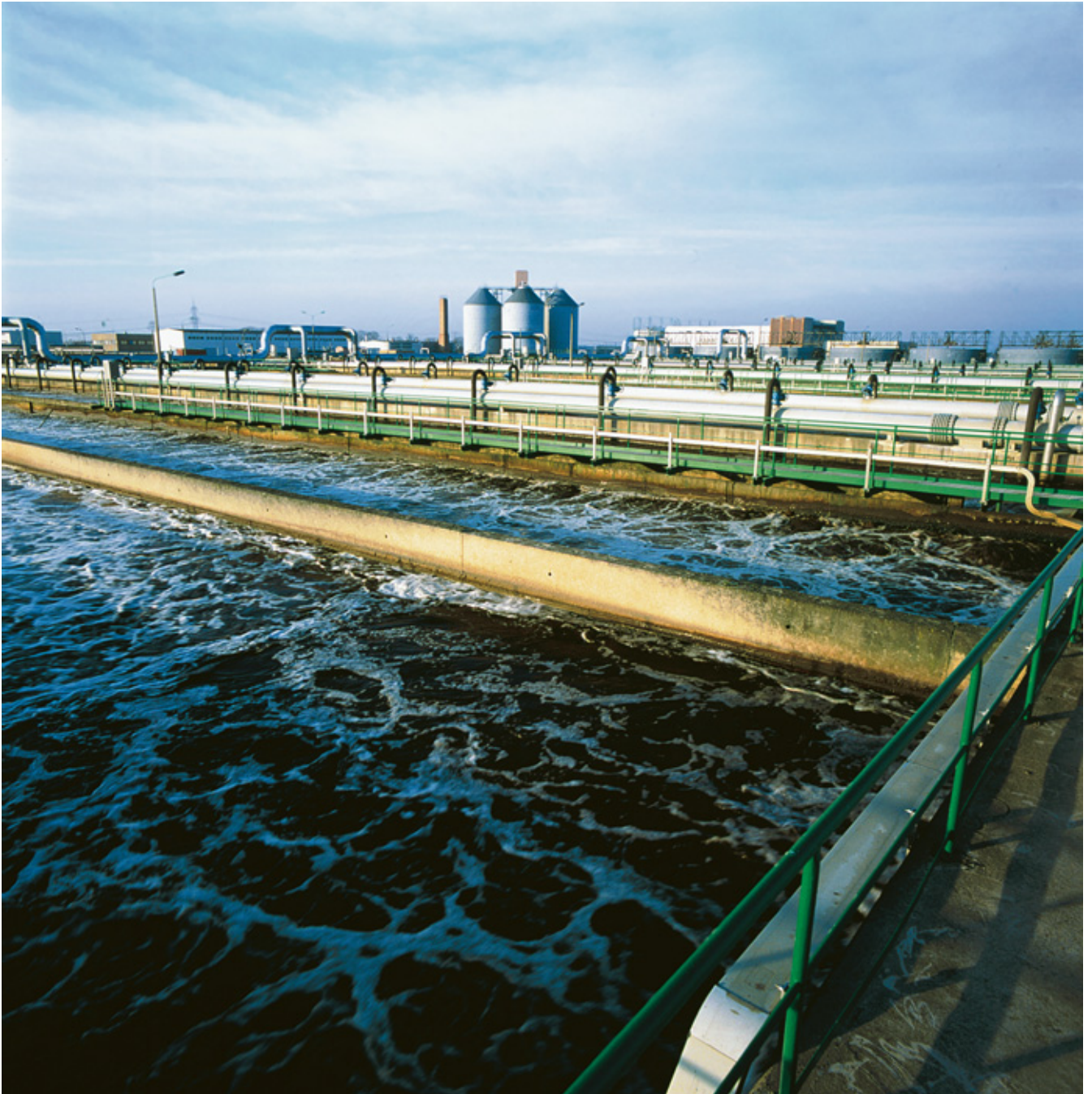
Abbildung 3.2-1 Klärwerk Schönertlinde, Blick auf die Belebungsbecken
