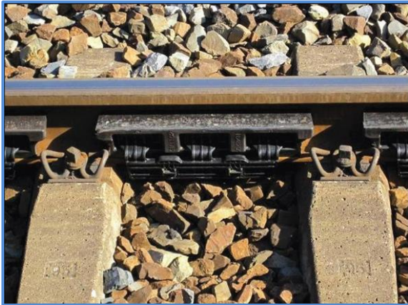
Abbildung 17: Schienenstegdämpfer
