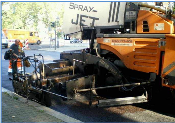
Abbildung 13: Maschine zur Fertigung des Dünnschichtasphaltes in der Gneisenastraße
