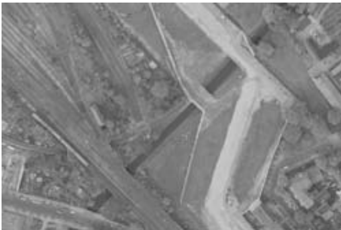
Abb. 8: Luftbild der Grenzanlagen 1989 - Bereich Bürgerpark / Pankegrünzug
