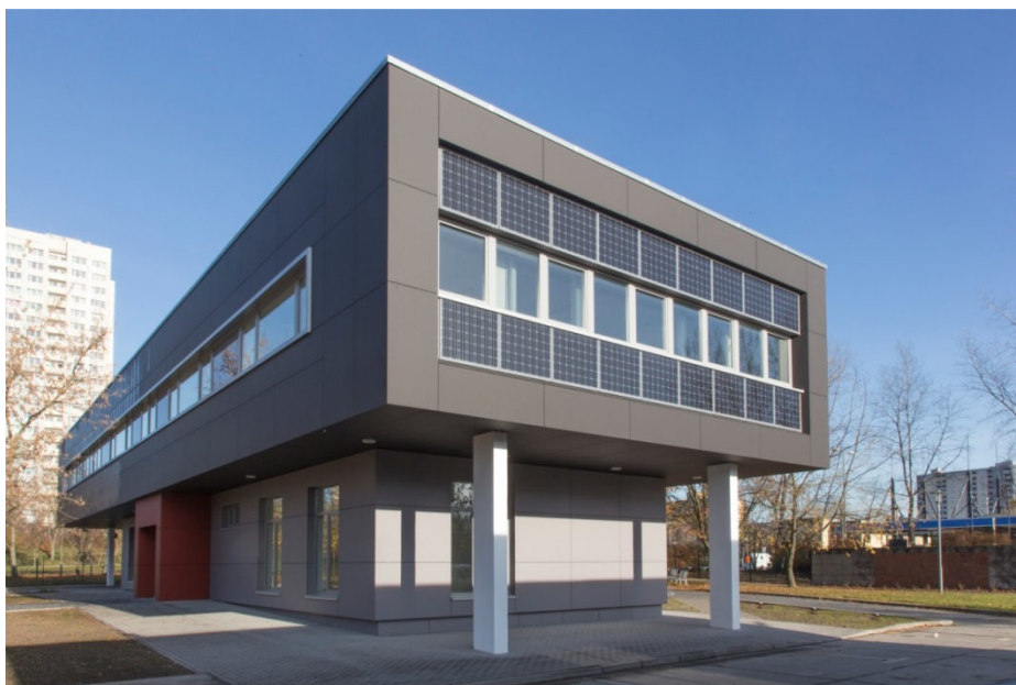
Abbildung 16: Alt-Friedrichsfelde 60, Saniertes Haus 14 mit PV-Anlage mit in die Fassadengestaltung integrierter PV-Anlage
