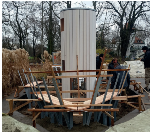
Hier entsteht ein Spielgerät für den Treptower Park © Bezirksamt Treptow-Köpenick
