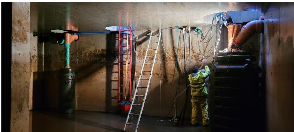
Abbildung 13 Einbauten in der Zisterne (Ortbeton) EVFBS in der Landsberger Allee 48 (Quelle: oikotec)
