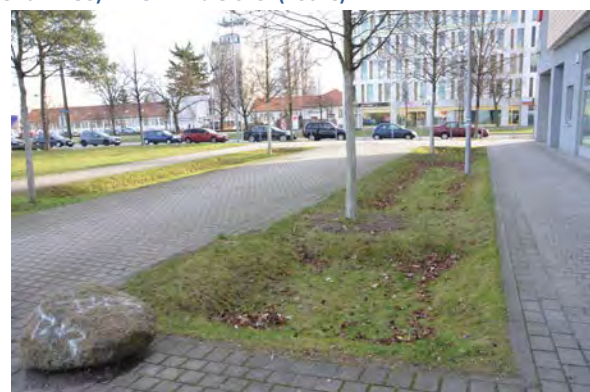
Mulden zur Entwässerung der Straßen und öffentlicher Wege in Berlin-Adlershof (hochC)
