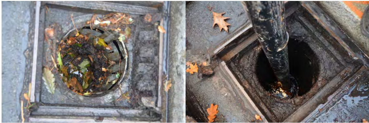
Straßenablauf mit Schlammraum und Eimer, Aussaugen des Schlammraumes (Sieker)
