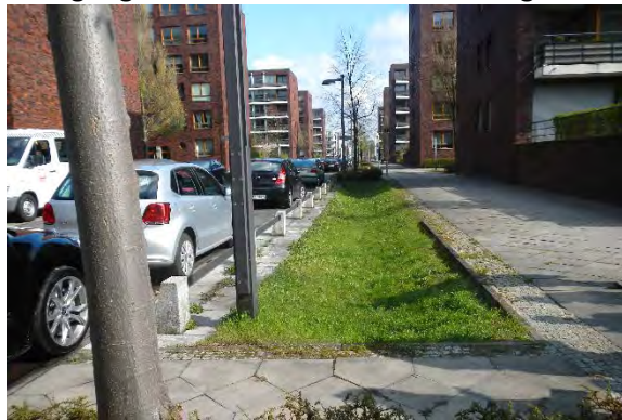
Beispiele von langjährig betriebenen Mulden-Rigolen-Systemen im Straßenseitenraum, Links: Wohnstraße in Berlin-Rummelsburg; Rechts: Gewerbegebiet in Hoppegarten bei Berlin (Sieker)
