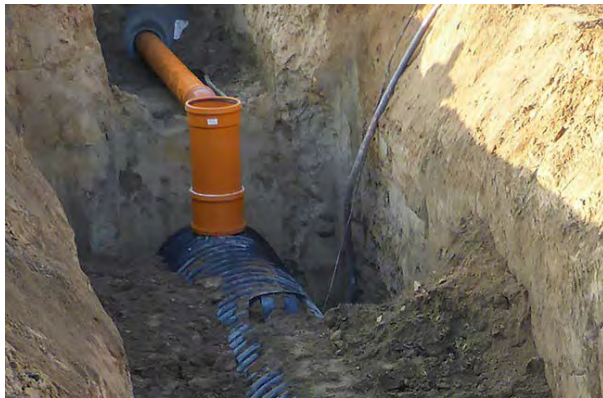
HydroMAXX mit HydroClean AF und vorgeschalteter Sedimentationsstufe (REHAU)
