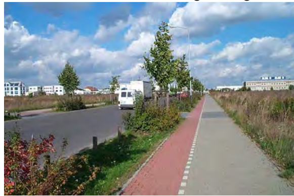
Beispiele von langjährig betriebenen Mulden-Rigolen-Systemen im Straßenseitenraum, Links: Wohnstraße in Berlin-Rummelsburg; Rechts: Gewerbegebiet in Hoppegarten bei Berlin (Sieker)
