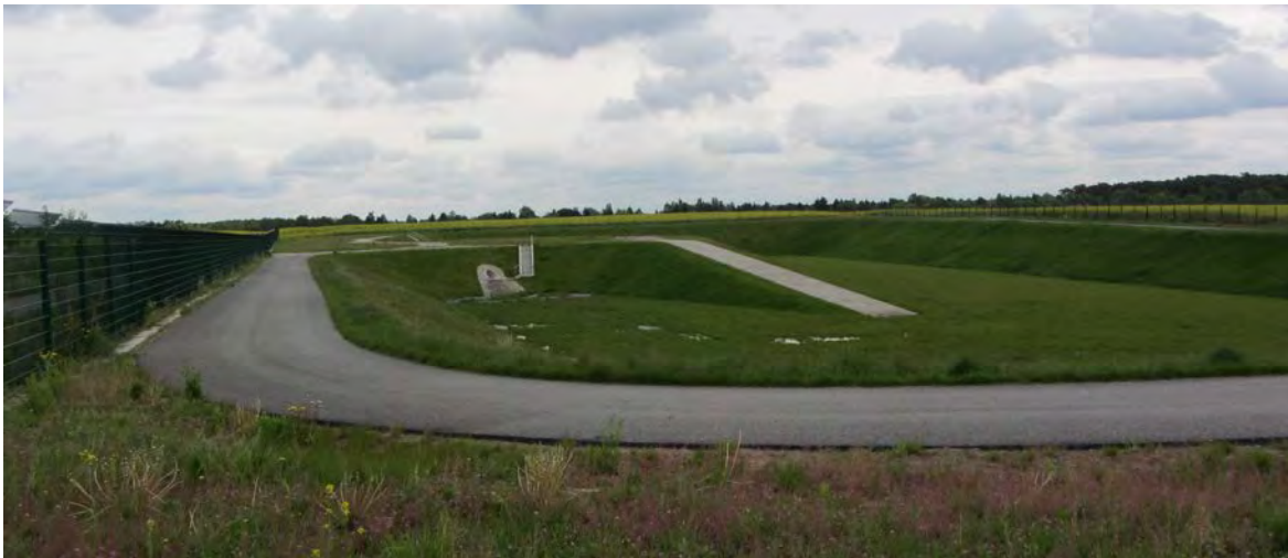
Großräumiges offenes Regenrückhaltebecken mit geböschten Wänden in Erdbauweise ohne Dichtung (BWB)
