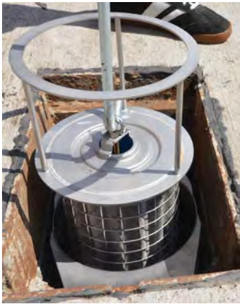
INNOLET G, Einsetzen der frischen Filterkartusche (UEP Berlin, BSR Betriebshof, Sieker)
