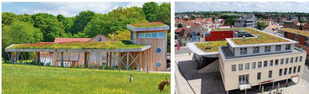
Links: Extensive Dachbegrünung (Fa. ZINCO) Rechts: Extensive Dachbegrünung (Fa. Optigrün International AG)
