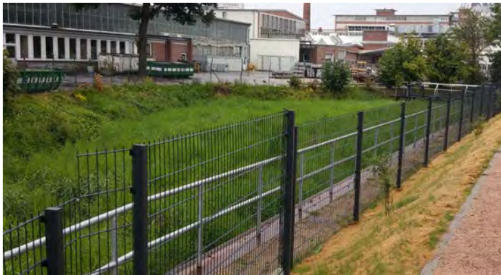
Schilfsedimentationsanlage (BUE Hamburg)
