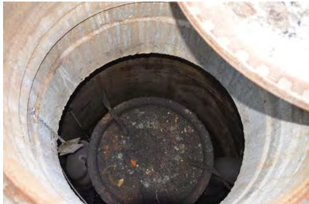
ViaPlus (MALL) in Betrieb (Sieker)
