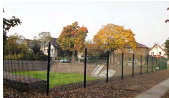
RRB, Steilwände (Gabionen) auf engem Raum (BWB)
