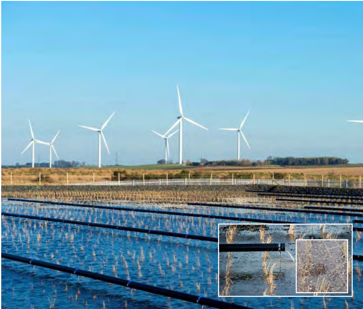
Belüfteter vertikaler Kiesfilter in Cowdenbeath, Schottland mit Detailfotos (ARM Ltd)
