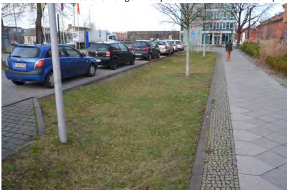
Mulden zur Entwässerung der Straßen und öffentlicher Wege in Berlin-Adlershof (hochC)
