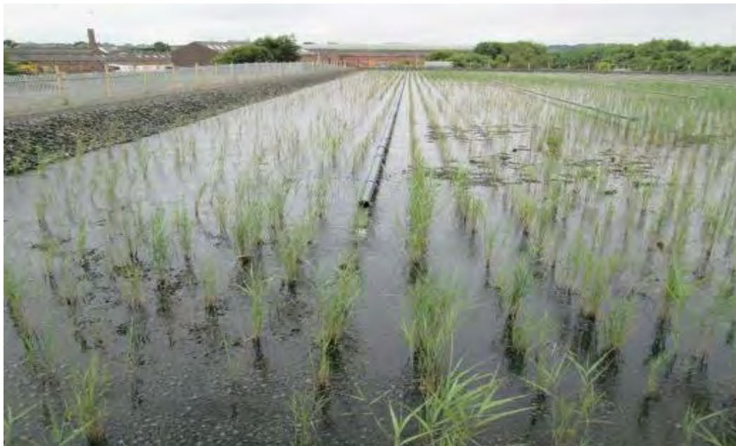
Belüfteter vertikaler Kiesfilter in Cowdenbeath, Schottland (ARM Ltd)
