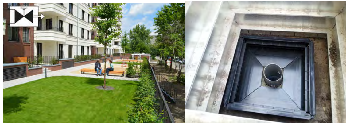
Links: Gründach (Optigrün); Rechts: Beispiel einer gezielten Drossel auf der Betondecke (Fa. Optigrün International AG)
