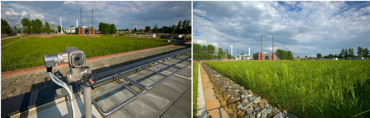
Retentionsbodenfilteranlage Berlin-Adlershof (BWB)
