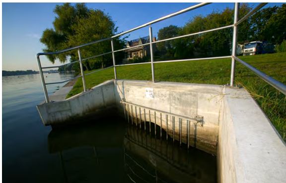
Regenklärbecken ohne Dauerstau Uferpark Schlierseestraße (BWB)
