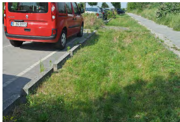
Links: Mulden-Rigolen-System am Krankenhaus Friedrichshain, gebaut Ende der 1990er Jahre; Rechts: Berlin-Bohnsdorf 2005 (Sieker)
