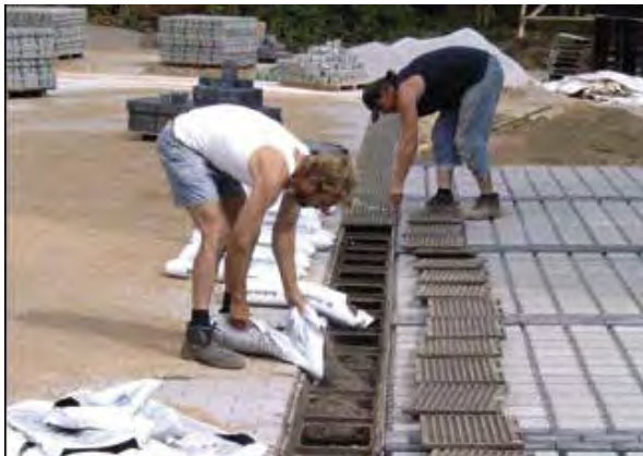
Einbau Funke D-Rainclean (Funke)
