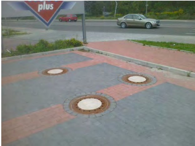
Links: Verbaute Anlage mit den Kontrollschächten (Sieker); Rechts: Funktionsprinzip SediSubstrator (Fränkische Rohrwerke)
