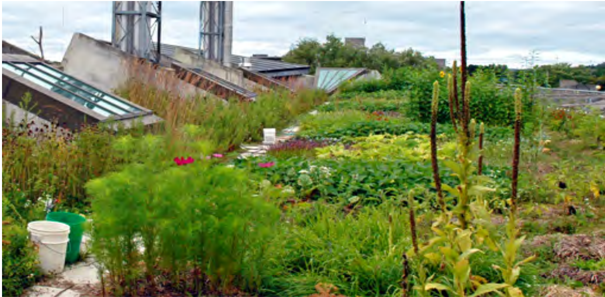
Intensive Dachbegrünung, Beispiel Fa. ZINCO
