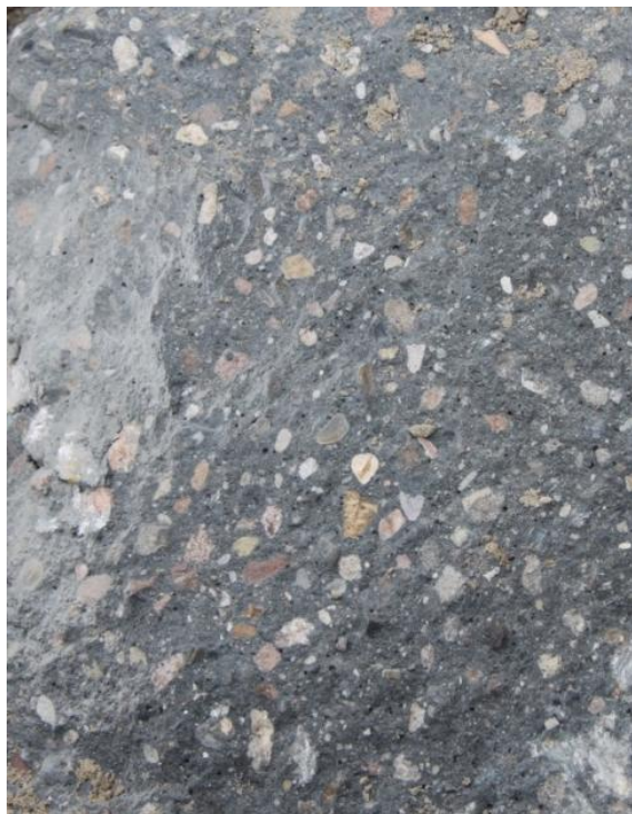
Abbildung 5-8: Aufgebrochener Schlitzwandbeton [Jacob, 25.07.2014]
