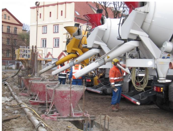
Abbildung 5-6: Betonage eines Schlitzwandabschnittes [Schmidt, 04.11.2013]
