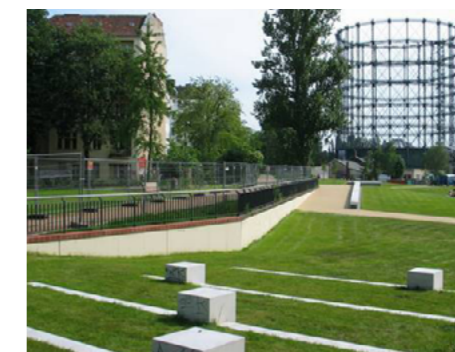
3 Der neugeschaffene Park „GASAG Nordspitze“ ist Teil des Grünzugs der sogenannten Schöneberger Schleife. Er wurde 2009 fertiggestellt. © BSM mbH
