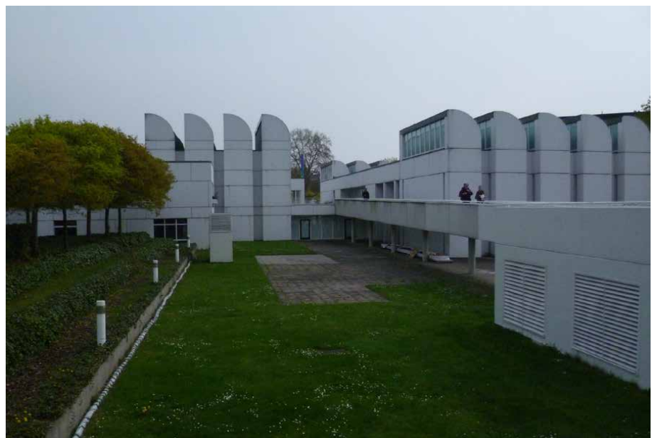
Foto: Innenhof mit Perspektive zum Bestandsgebäude – Zustand vor Beginn der Bauarbeiten
