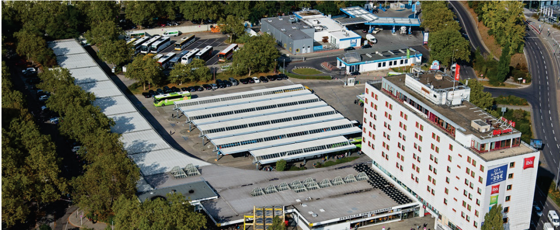
Luftaufnahme ZOB vor dem Umbau und der Kapazitätserweiterung (o.J., Quelle: https://zob.berlin/de/ueber-uns )
