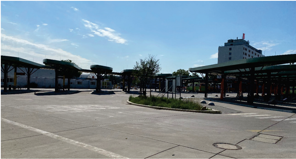
Blick von nördlichem Bereich der Stützwand auf die Grünfläche am Mittelbahnsteig 20 (Stand August 2021)
