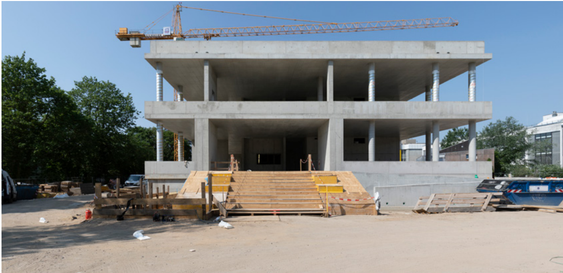
Rohbau am 19. Juni 2019, Eingangssituation (weitere Fotos in der Anlage), Foto: Robert Patz
