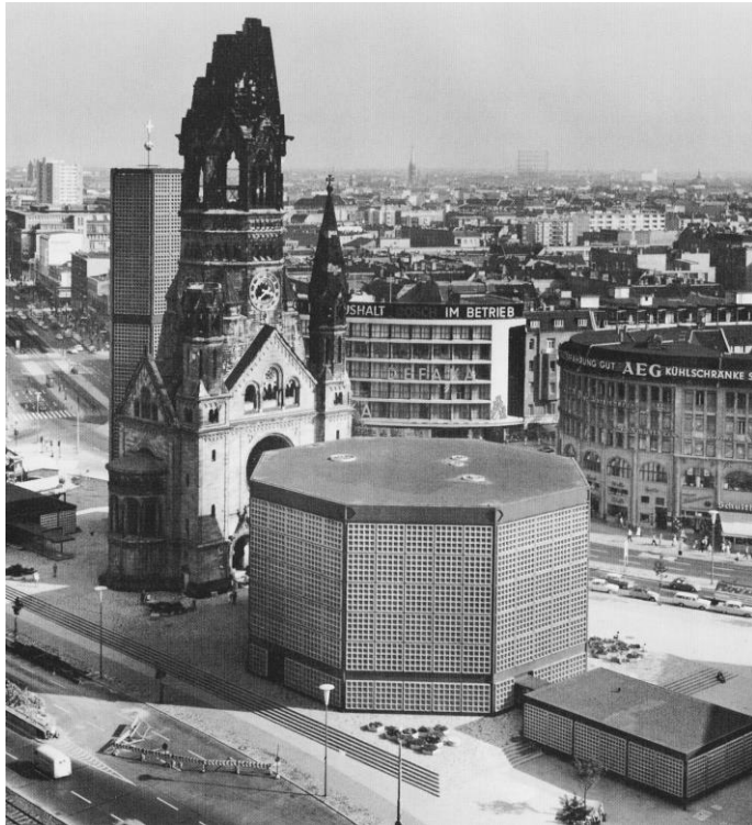
Luftaufnahme des Ensembles von Nordwesten, 1960er Jahre (Foto: Horstheinz Neuendorff, saai | Südwestdeutsches Archiv für Architektur und Ingenieurbau, Karlsruhe, Nachlass Egon Eiermann)
