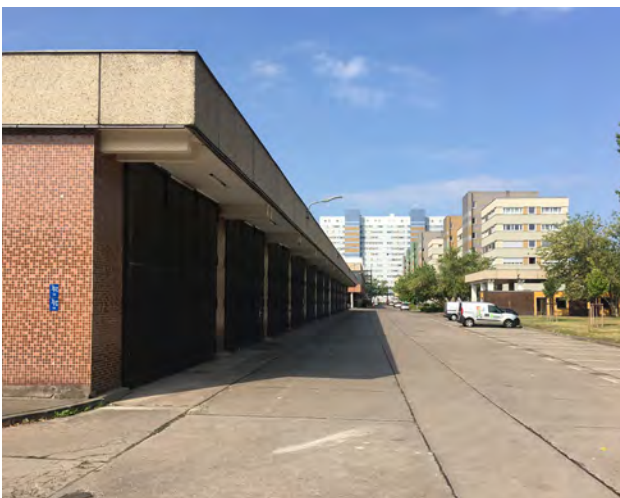
Blick nach Westen, links Haus 16 (Foto: BSF)
