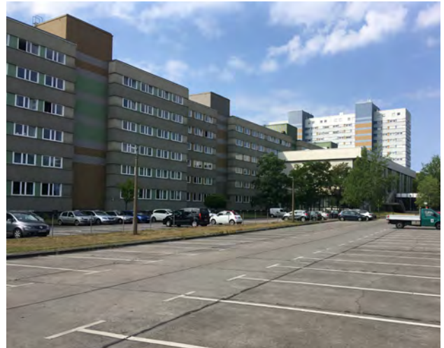
Blick nach Westen, links Haus 1, im Vordergrund der Parkplatz (Foto: BSF)
