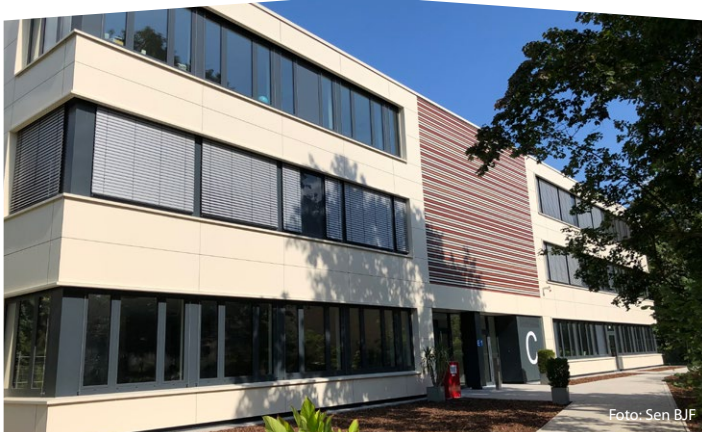
Eingangsbereich der Schule am Park
