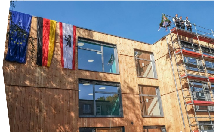
Richtfest in Lichtenberg für die neue Grundschule
