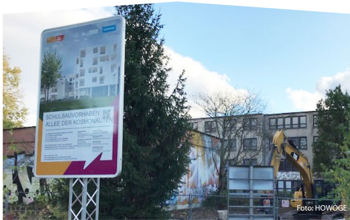
HOWOGE Abbruch Altbestand AdK 1
