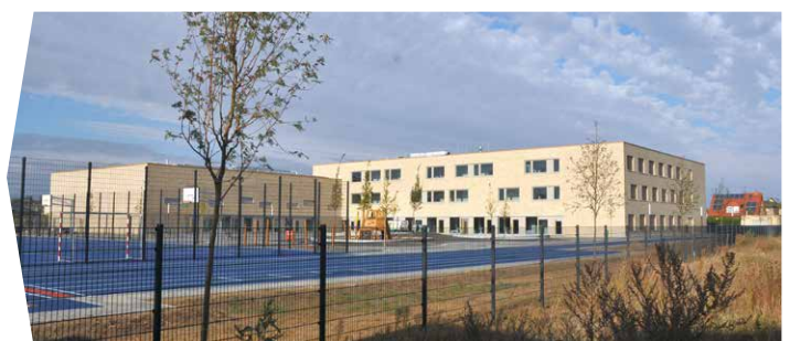
Neubau der Fuchsberg-Grundschule
