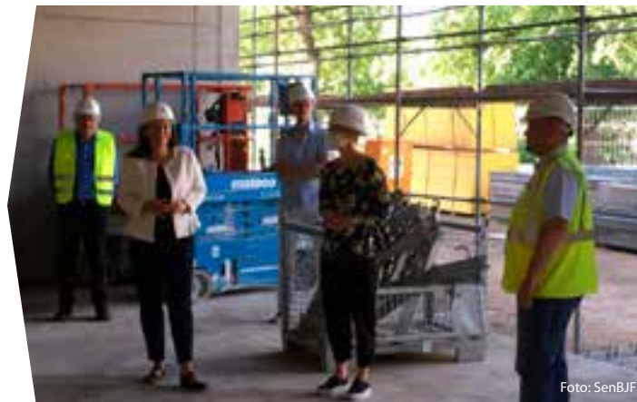
Senatorin Sandra Scheeres und Senatsbaudirektorin Regula Lüscher, Baustellenbegehung Jeanne-Barez-Grundschule
