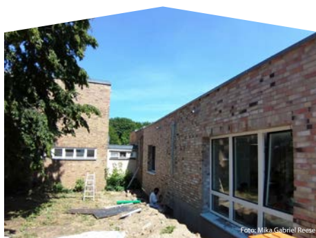
Der fertige Erweiterungstrakt
