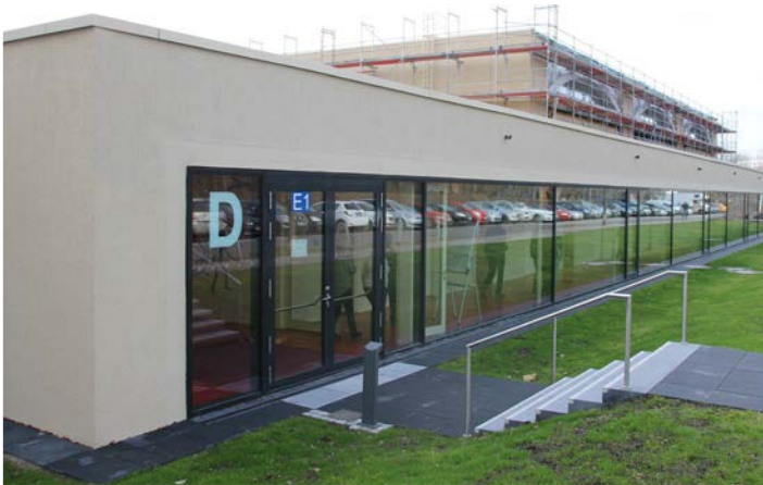
Neubau der Schulsporthalle des Hans-und-Hilde-Coppi-Gymnasiums
