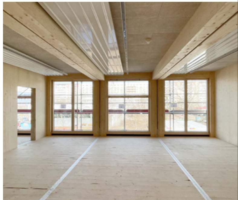
Innenansicht Rohbau Foto: SenStadtWohn
