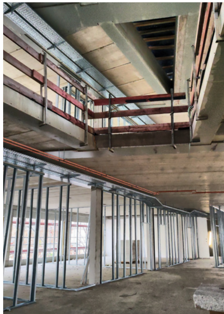
Baustellenansicht Foto: SenStadtWohn
