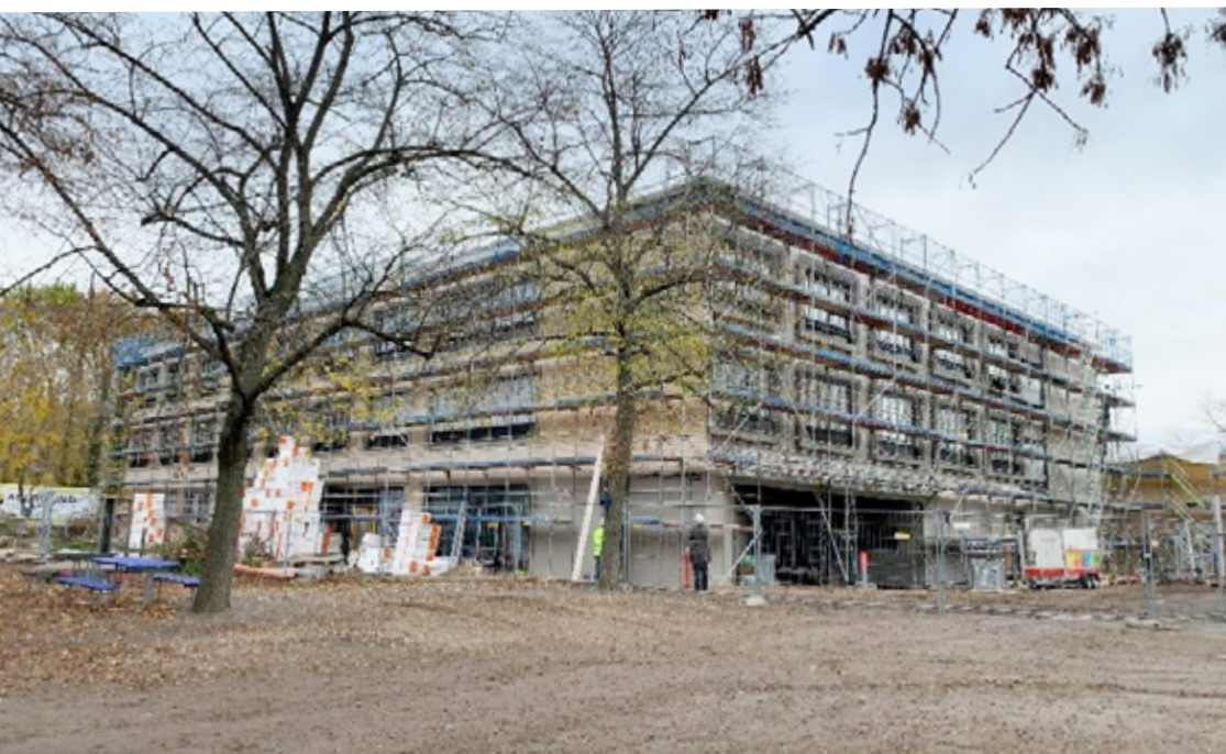
Baustelle Jeanne-Barez-Schule Foto: SenStadtWohn
