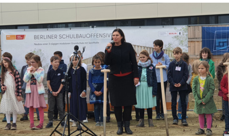
Senatorin Scheeres beim Spatenstich für die neue Typengrundschule in Pankow Ende September 2021 Foto: SenBJF
