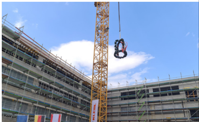
Der Richtkranz wird gehoben Foto: SenBJF
