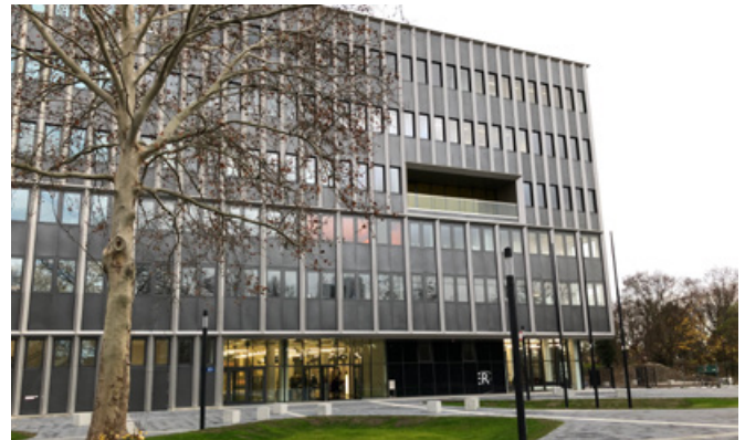
Eingangssituation Schulgebäude Foto: SenBJF
