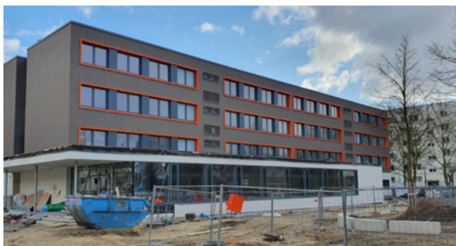
Ansichten Reaktivierung Grundschule Wartiner Straße Fotos: BA Lichtenberg
