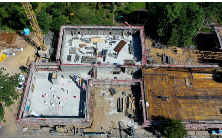
Baustelle der neuen Panke-Schule von oben Foto: SenBJF
