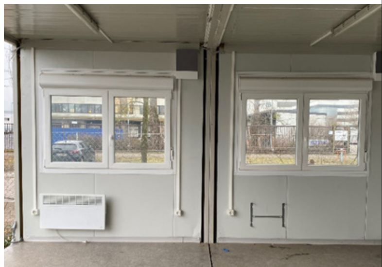
Innenansicht eines Bestandscontainers Foto: BIM
