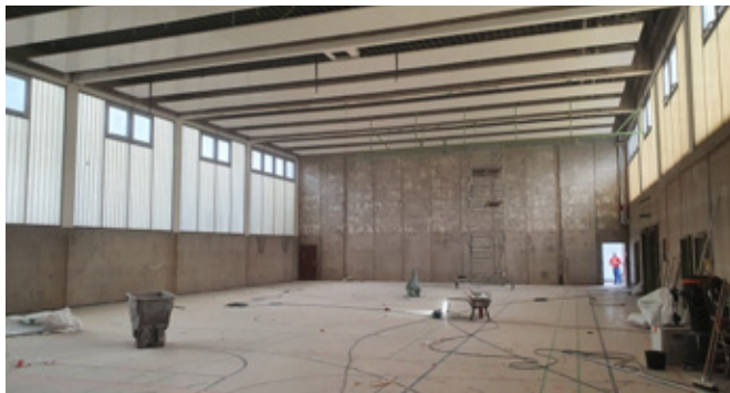
Sporthalle vor der Sanierung Foto: BIM
