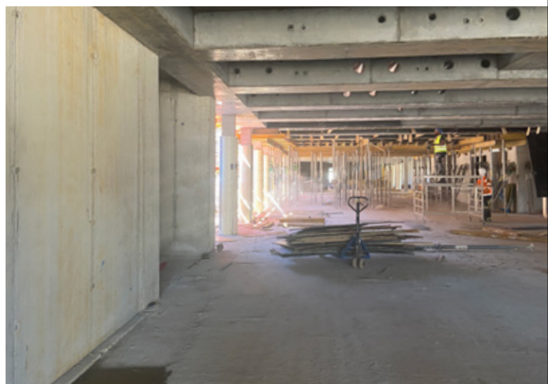
Innenansicht Rohbau Foto: SenBJF
