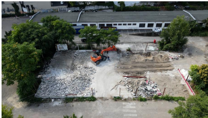
Abb.: Abrissarbeiten Baufeld Süd, BIM GmbH / GPlant, 2022.
