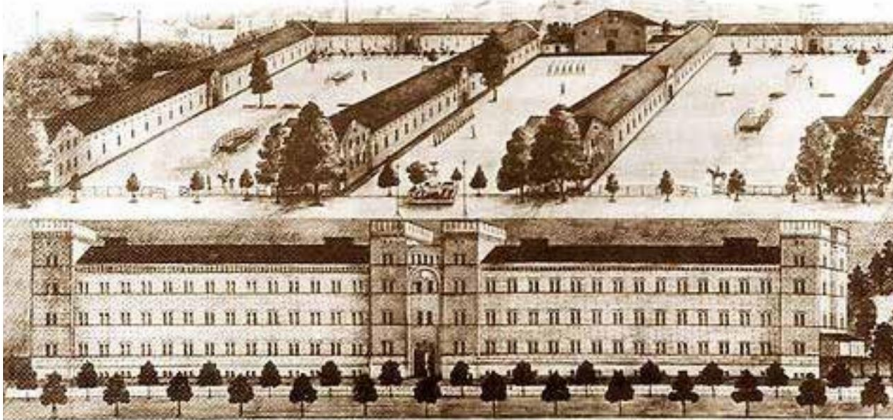
Abb.: Garde-Dräger-Kaserne, 1898, Denkmalpflegeplan Finanzamt Kreuzberg, büro west, 2021.
