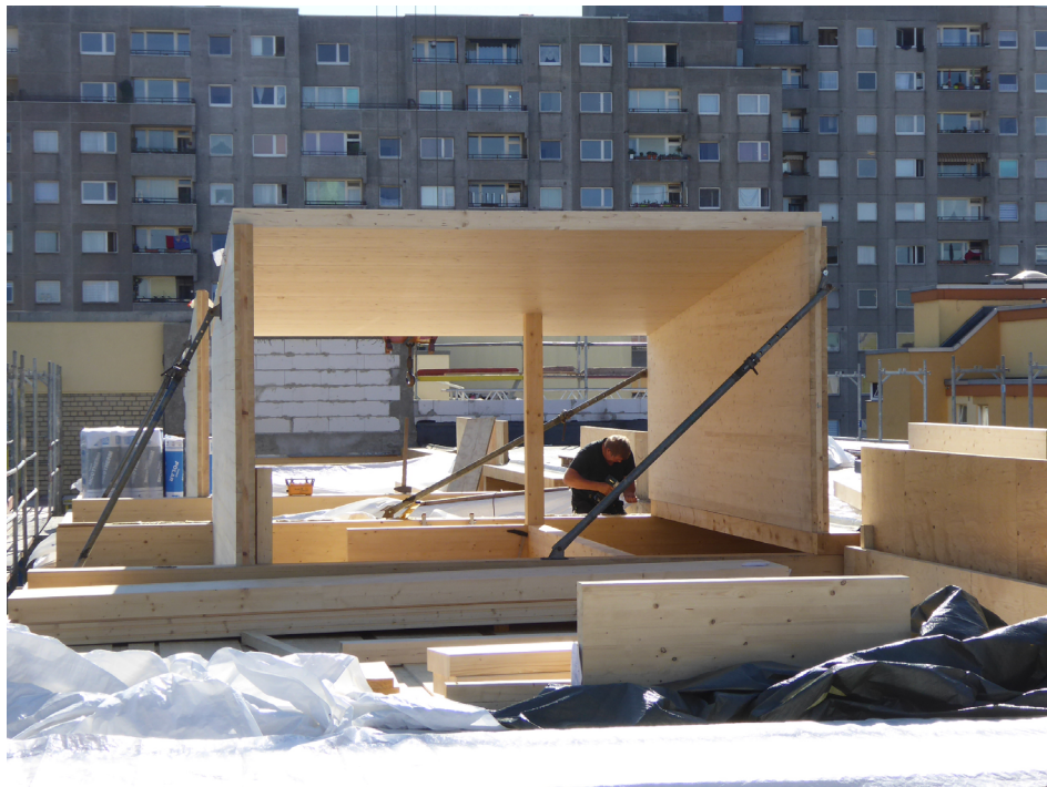
Dachaufstockung Wassertor (Preisträger des Berliner Holzbaupreises in der Kategorie Bauen im Bestand)
