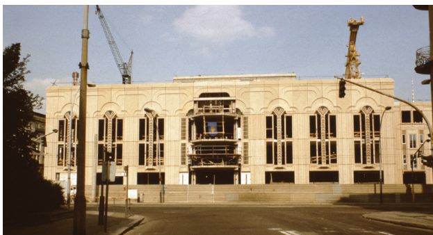
Abb. 10 Friedrichstadtpalast im Bau, 1983 Foto: Archiv Professur Denkmalpflege und Bau- geschichte, Bauhaus-Universität Weimar
