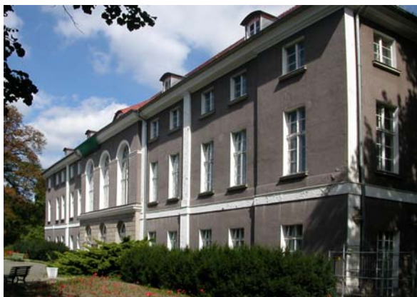
Westfassade mit Glaskröselputz (Foto: F. Hesse)
