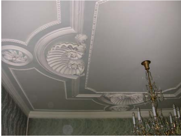
Barockdecke im Obergeschoss, Raum 110 (Foto: F. Hesse)
