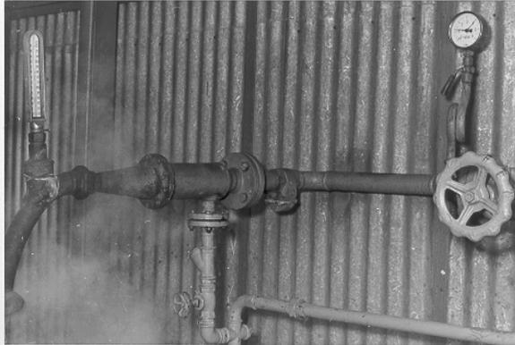
Hauptschieber für Heißdampf, darüber das Druckmanometer, der Heißdampf-Kaltwassermischer mit vorgebautem Schnellschlußventil und einem Thermometer.
