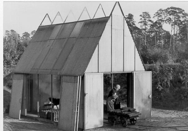
Zum besseren Abzug der entstehenden Dämpfe sind das Dach sowie die Seitenwände abnehmbar. Das Anfahren der Granaten bzw. Bomben erfolgt mit einer Pritschenlore.
