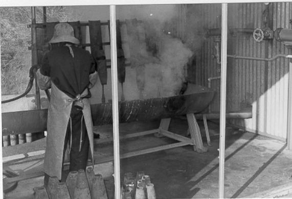
Der ausgedüστε Sprengstoff fließt aus der Düswanne über eine Schale in ein Absetzbecken, welches außerhalb des Düsschuppens aufgestellt ist.
