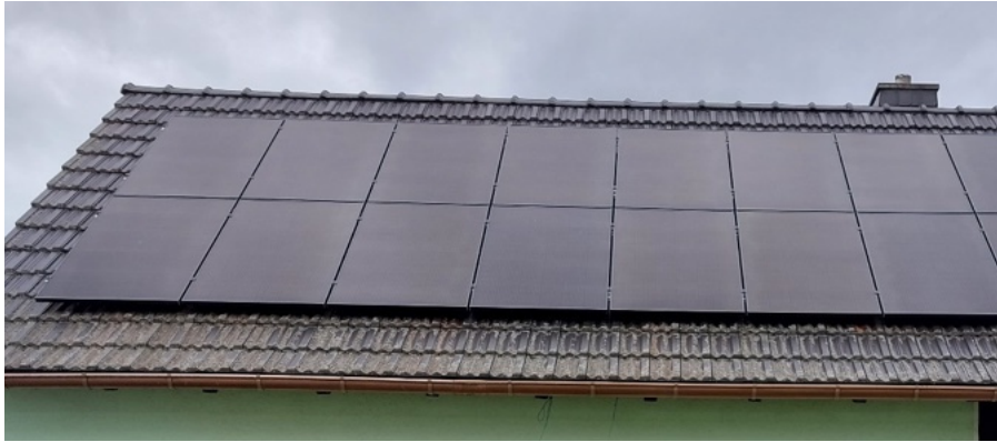
Abb. 4 Beispiel für eine Anlage mit „All Black“ Modulen und entsprechend dunklen Befestigungen.
