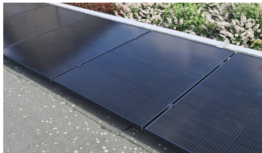
Abb. 3 „All Black“-Module aus der Nähe, gut erkennbar ist die matte Oberfläche mit der nur schwach erkennbaren inneren Zellstruktur.
