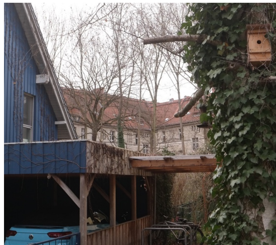
Abb. 15 Rückseitige Dachflächen vom Köberlesteig gesehen
