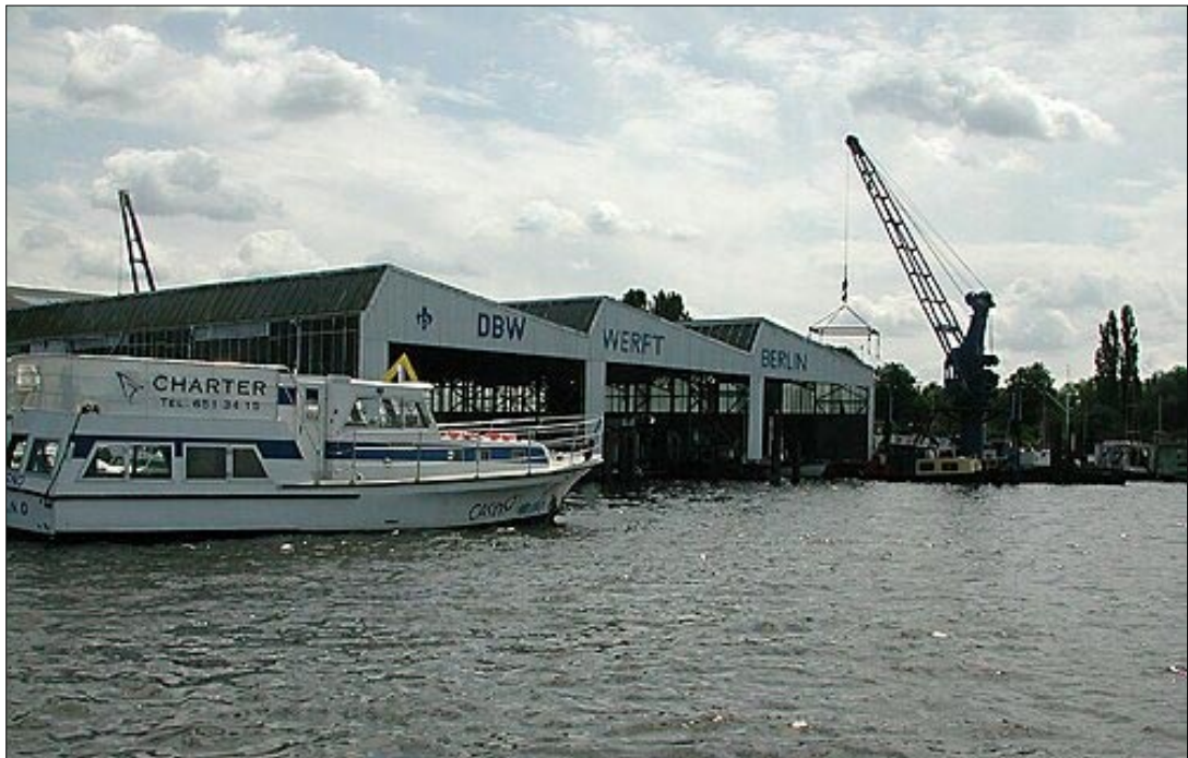
Die ehemalige Binnenwerft Berlin, seit 2002 Wassersportzentrum Dahme.
