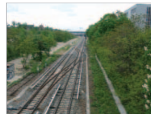
Bahngraben mit möglicher Wegführung neben den Gleisen
