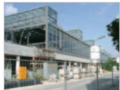
Bahnhof Südkreuz, Vorplatz Ost, 2005 im Bau
