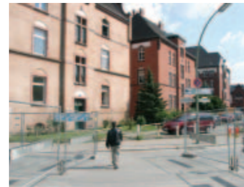
Kaserne General-Pape-Straße vom Bahnhofsvorplatz Ost (im Bau)
