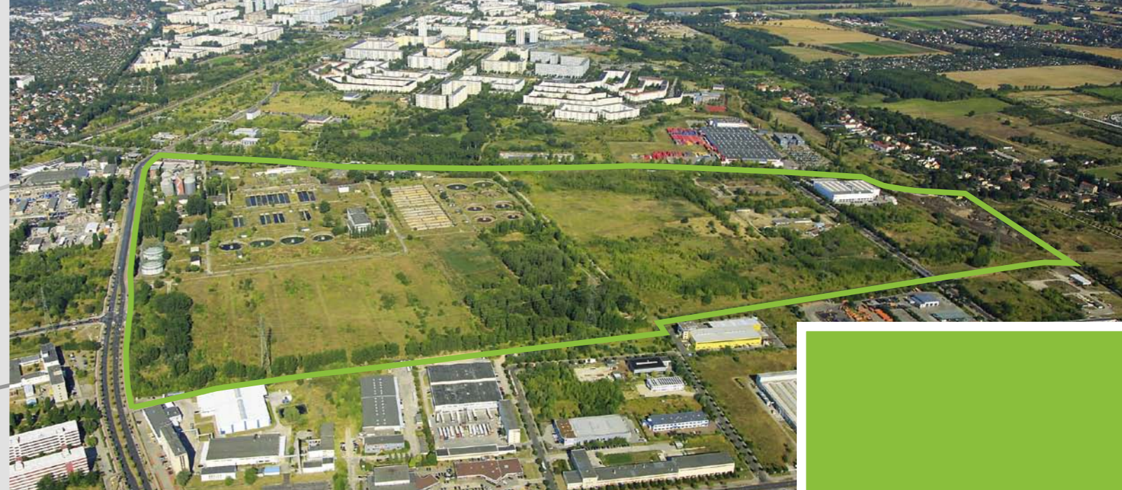
Das Planungsgebiet für den künftigen Clean Tech Business Park Berlin-Marzahn (Foto: Stefan Otto – Aperçu Verlagsgesellschaft)
