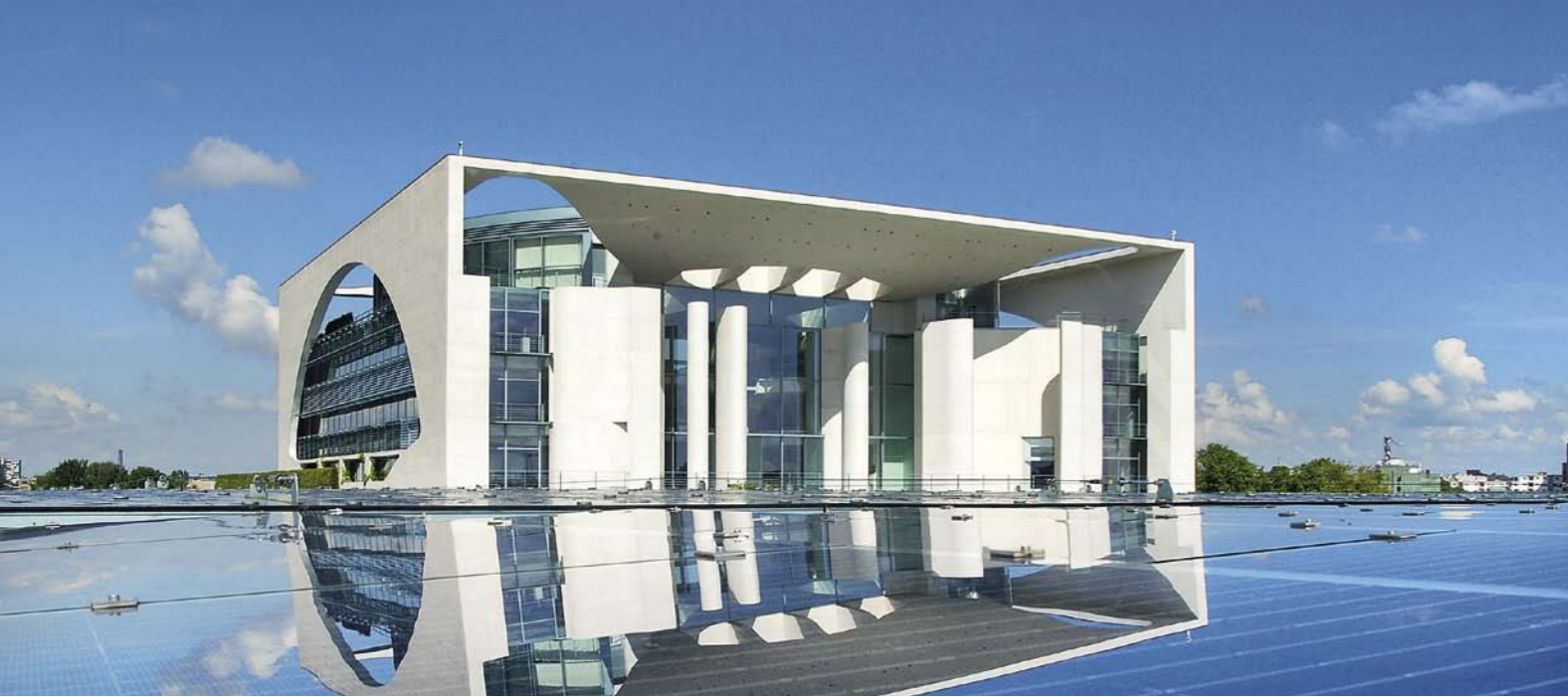
Das Kanzleramt (Foto: BSW-Solar/Langrock)
