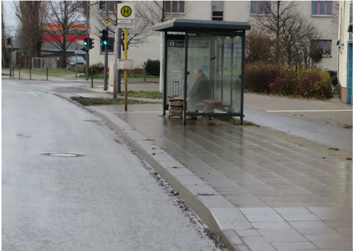
Abb. 33: Barrierefreie Bushaltestelle (am Glienicker Weg) mit Hochbord und wettergeschützter Sitzgelegenheit
