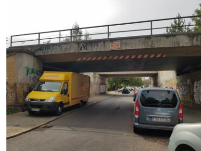
Unterführung S-Bahn Puderstraße, Quelle: BI
