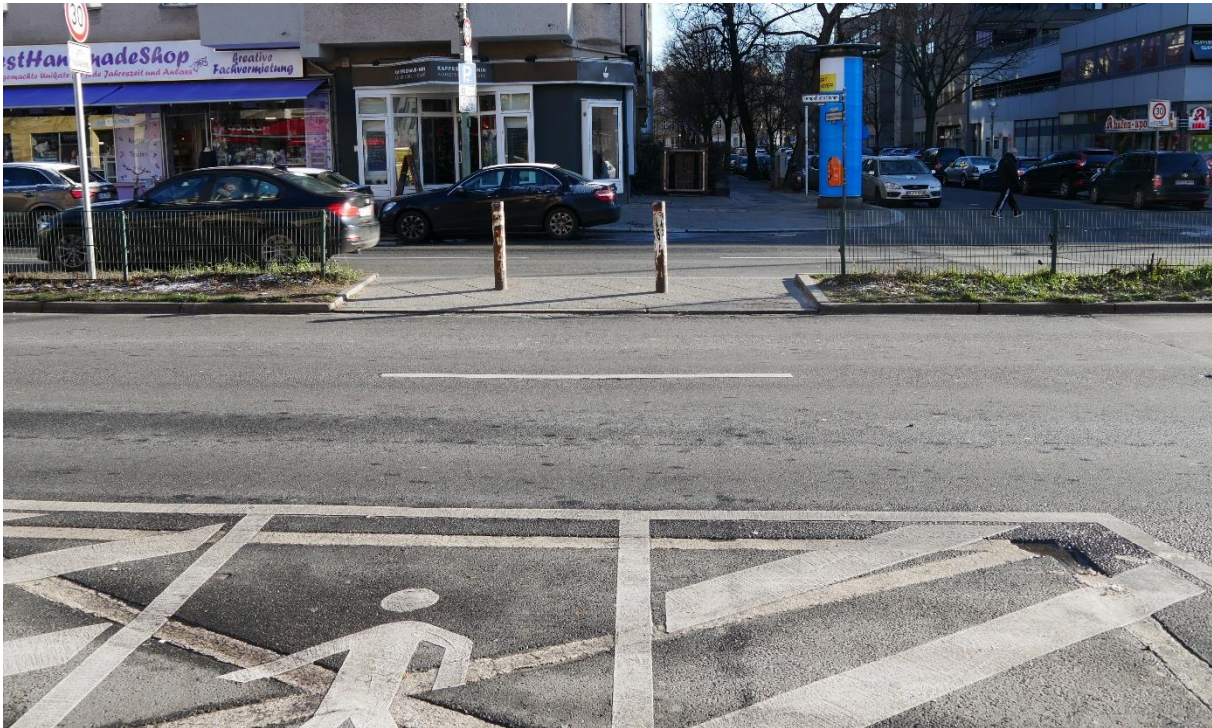
Abbildung 4: Ungesicherte Querungshilfe an Kreuzung Tempelhofer Damm/der Theodor-Francke Straße: Markierungen insb. für sehbehinderte Menschen schwer/nicht erkennbar, Poller nicht kontrastreich markiert, Übergang zugeparkt
