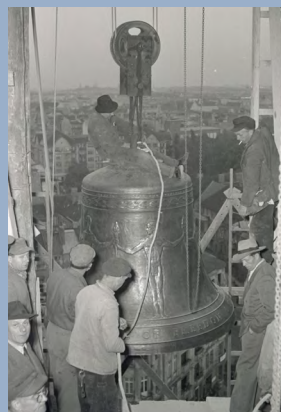
Montage der Glocke im Schöneberger Rathaus-turm / Installation of the bell in the Schöneberg City Hall tower
