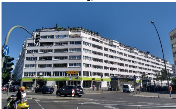
Abbildung 13: Sanierter Gebäudekomplex an der Else-Lasker-Schüler-Str. Ecke Karl-Heinrich-Ulrichs-Str. (straßenseitig)
