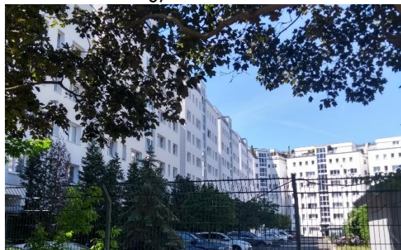
Abbildung 14: Sanierter Gebäudekomplex an der Else-Lasker-Schüler-Str. Ecke Karl-Heinrich-Ulrichs-Str. (hofseitig)
