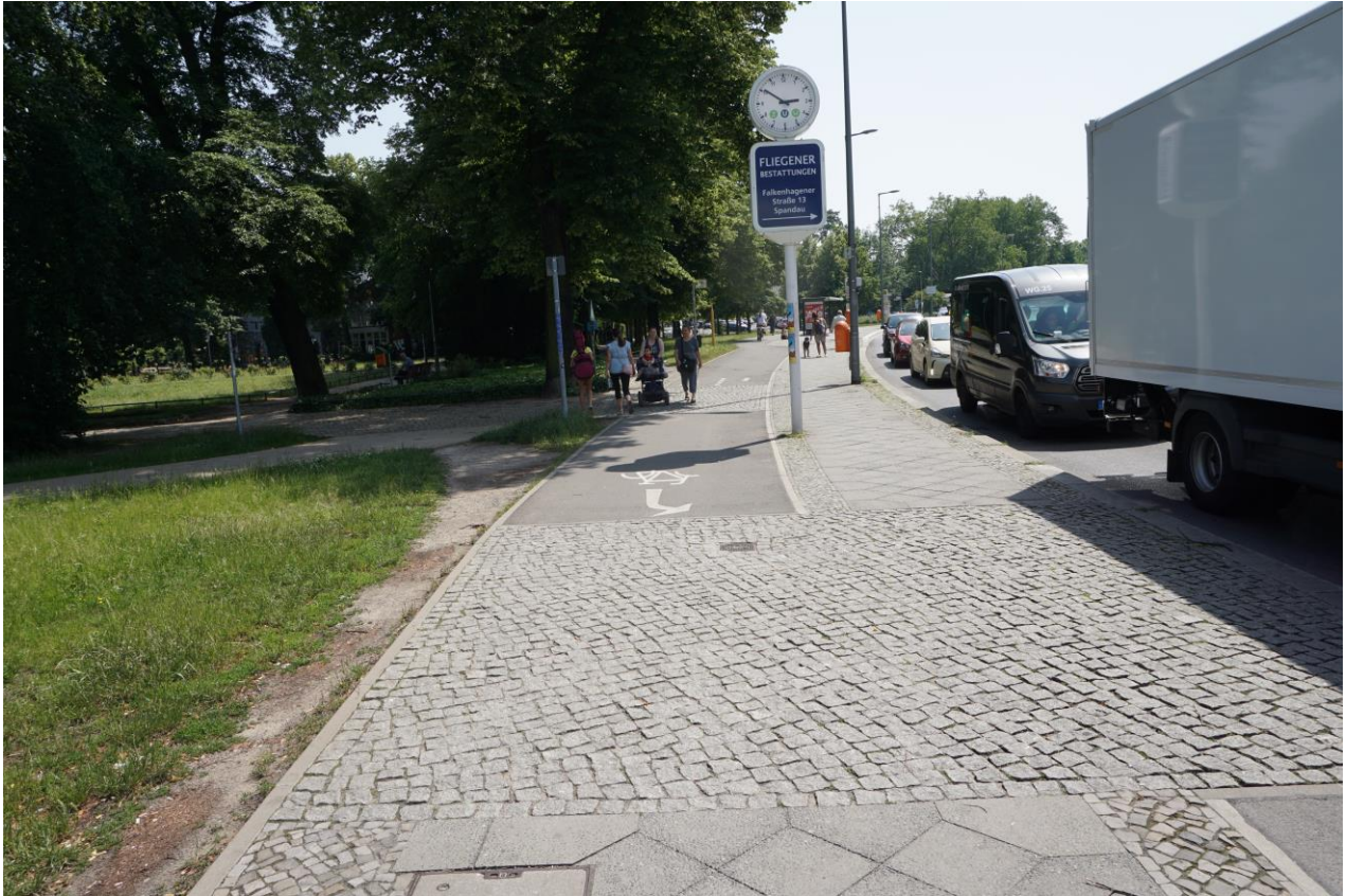
Foto 2: Einmündung des Fußweges (Hauptwegeverbindung zwischen Spandau-Neustadt und Altstadt Spandau) in den Neuendorfer Straße. Fehlende Wegeleitung für Fußgehende, diese fühlen sich an den äußersten Rand des Fußweges gedrängt. Optische Vorfahrt für Radfahrende. (Quelle: Willi Loose)
