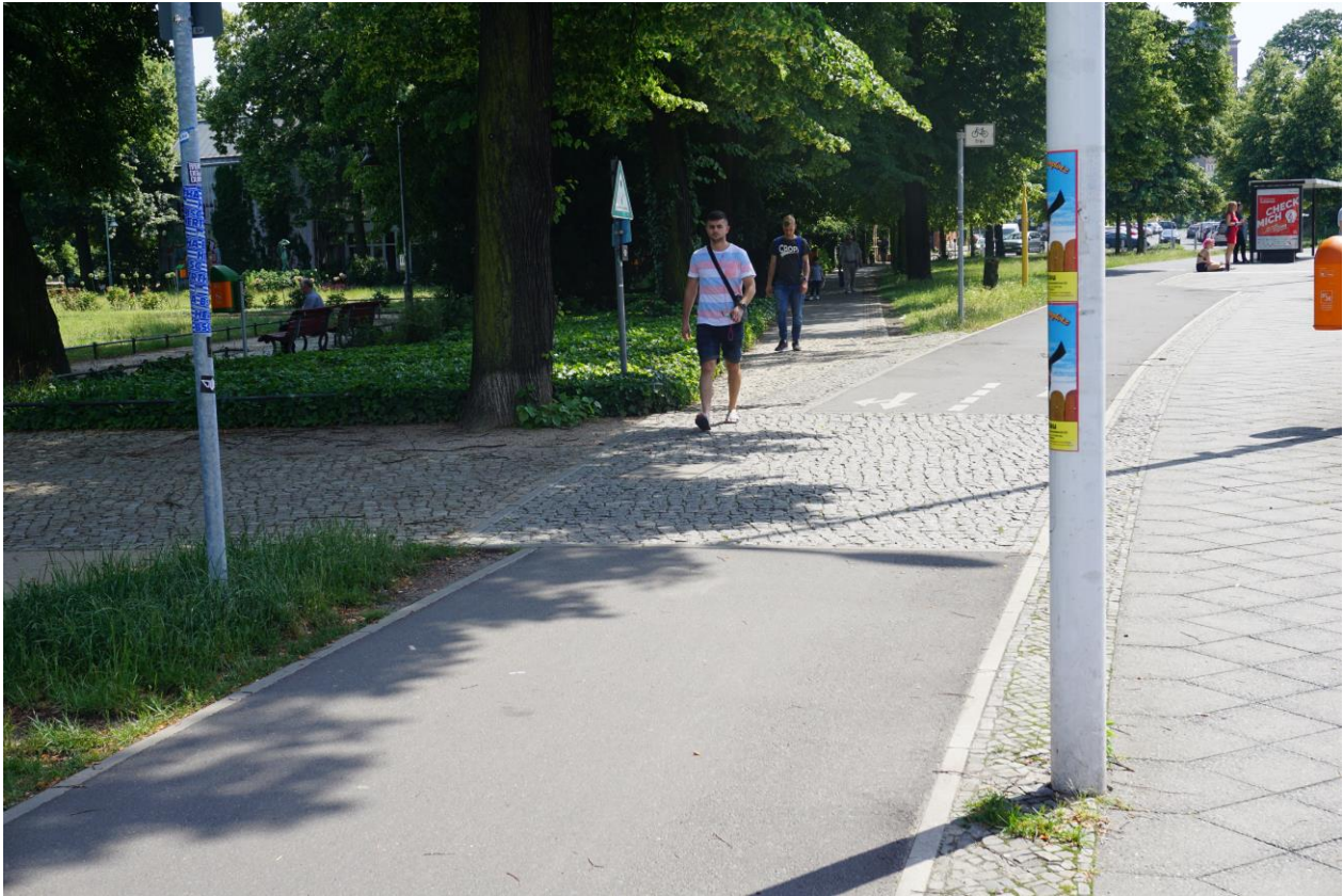
Foto 1: Einmündung des Fußweges (Hauptwegeverbindung zwischen Spandau-Neustadt und Altstadt Spandau) in den Neuendorfer Straße. Fehlende Wegeleitung für Fußgänger, diese fühlen sich an den äußersten Rand des Fußweges gedrängt. Optische Vorfahrt für Radfahrende. (Quelle: Willi Loose)
