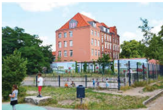
Grundschule am Birkenhain
