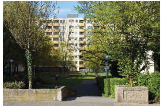
Bebauung und Wohnumfeld Heerstraße
