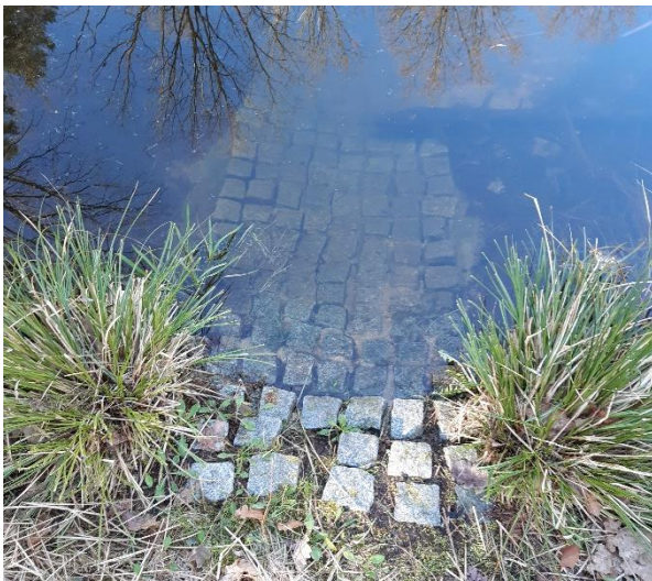
Abb. 2: Pflastersteine am Rand des Ersatzlaichbiotops, an denen der Wasserstand abgelesen werden kann (Quelle: BA Reinickendorf)
