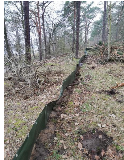
Abb. 1: Amphibienschutzzaun der Hinwanderung auf der Waldseite. (Quelle: BA Reinickendorf)
