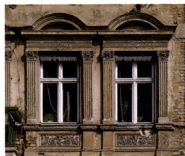
Gut erhaltene historische Fenster
