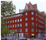
Überbetonung des Eckgebüdes (Dach, Farbe)
