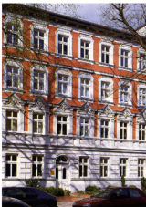
Originalgetreu sanierte Fassade/Dachausbau
