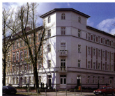
Beispielhaft instandgesetzte Eckfassade
