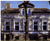
Originalgetreu sanierte Fassade
