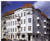
Instandgesetzte abgestuckte Fassade
