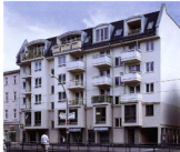
Mangelfhaft gestaltete Neubaufassade
