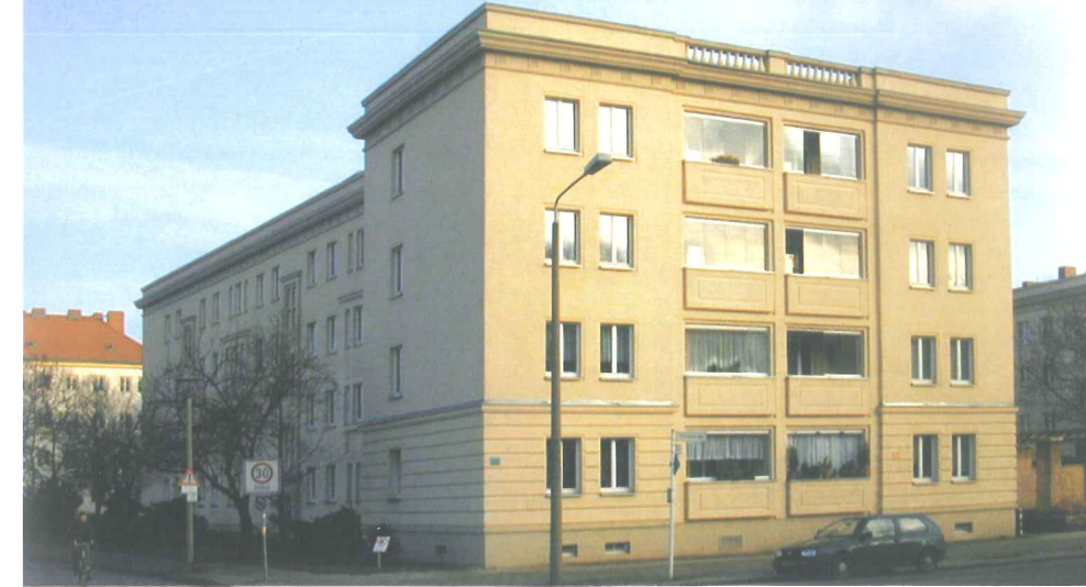
Kopfbau der Wohnbebauung an der Goethe-/ Ostseestraße (Denkmalensemble) (Bauzeit 1950er-Jahre)
