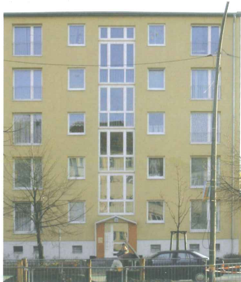
Erschließungsseite der sanierten Wohnblöcke (Typ QP) an der Prenzlauer Allee
