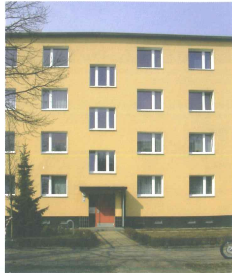
Beispielhafte Sanierung Typ Q3A/ Hauseingangsbereich (Bauzeit 1960er-Jahre)
