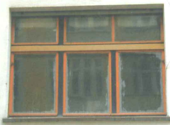
Originale Farbgebung der Fenster in der denkmalgeschützten Bebauung an der Rietzestraße
