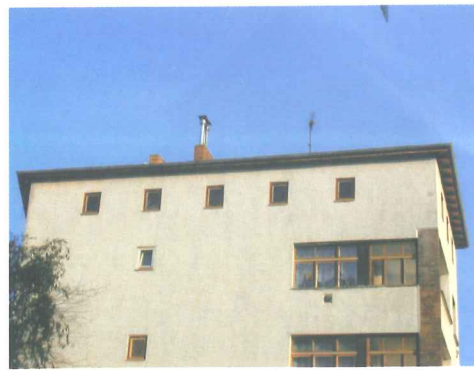
Dachabschluss mit Dachüberstand und Drempelfenstern (Detail Kopfbau an der Erich-Weinert-Straße)
