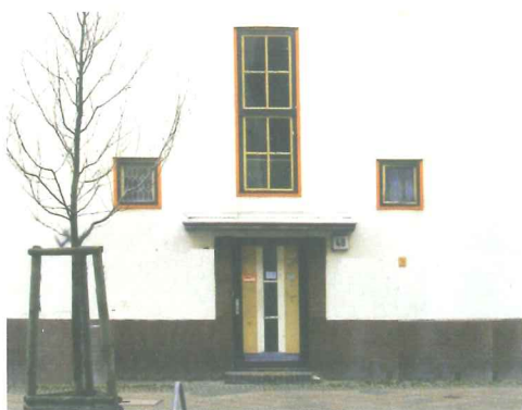
Fassadendetail Hauseingangsgestaltung mit Klinkerband im Sockel- u. Türbereich und vertikalem Fensterband (Naug, Str. 48)
