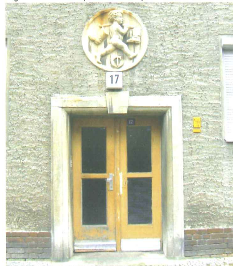
Hauseingangsgestaltung mit Werksteineinfassung an der Bebauung der 1930er-Jahre (Gubitzstraße 17)
