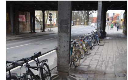
Maßnahme: Stadtkologisches Mobilitätskonzept mit Fahrradwegennetz Wegeanbindungen an den Bahnhof differenziert nach Fuß- und Fahrradwegen
