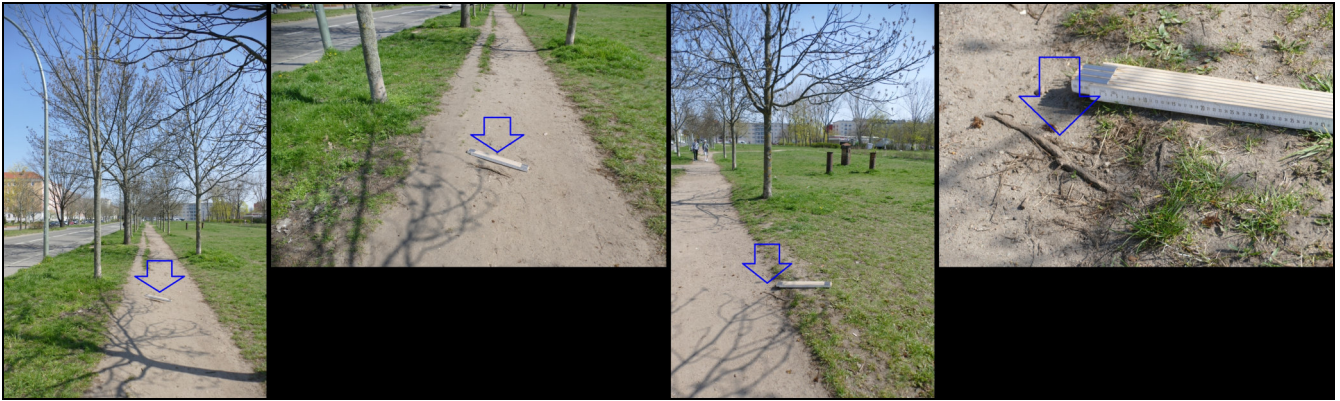
Bild Nr.4: direkt an der Oberfläche verlaufende Wurzeln des doppelreihigen Eschenbestandes.
