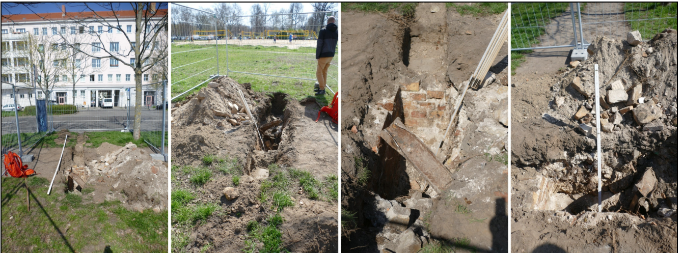
Bild Nr. 2: erster, südwestlicher der beiden Suchschachtungsverläufe. Der hohe Bauschuttanteil sowie die in rund 50 cm Tiefe beginnenden, alten Fundamente sind gut erkennbar. Es liegt eine Wurzelkonzentration der Eschen in Tiefenhorizonten von 0 cm bis 50 cm vor.
