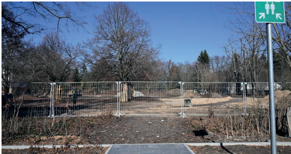
Im Bereich des Grünen Bandes (hinter dem Bauzaun) entsteht derzeit ein großer Spielplatz.
