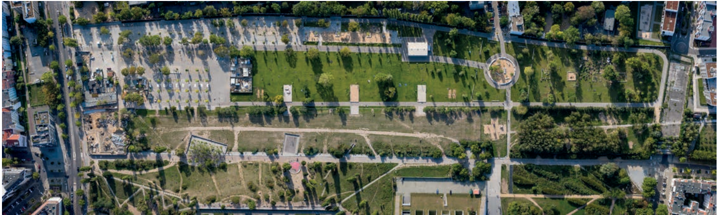
Luftaufnahme mit der Erweiterung im oberen Bereich und dem "alten" Mauerpark im unteren Bereich, Foto: Manuel Frauendorf Fotografie
